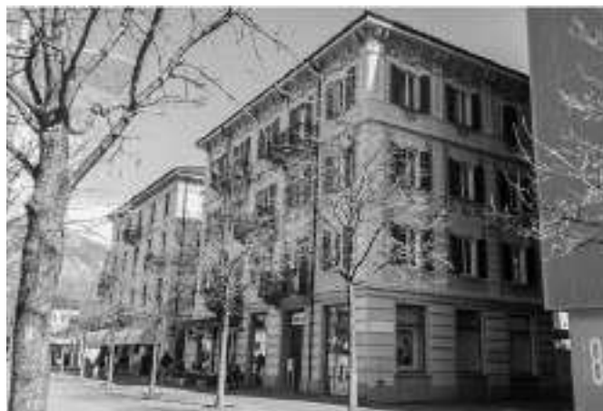
SEDE DELL'UFFICIO DI BELLINZONA, PIAZZA SIMEN 7
